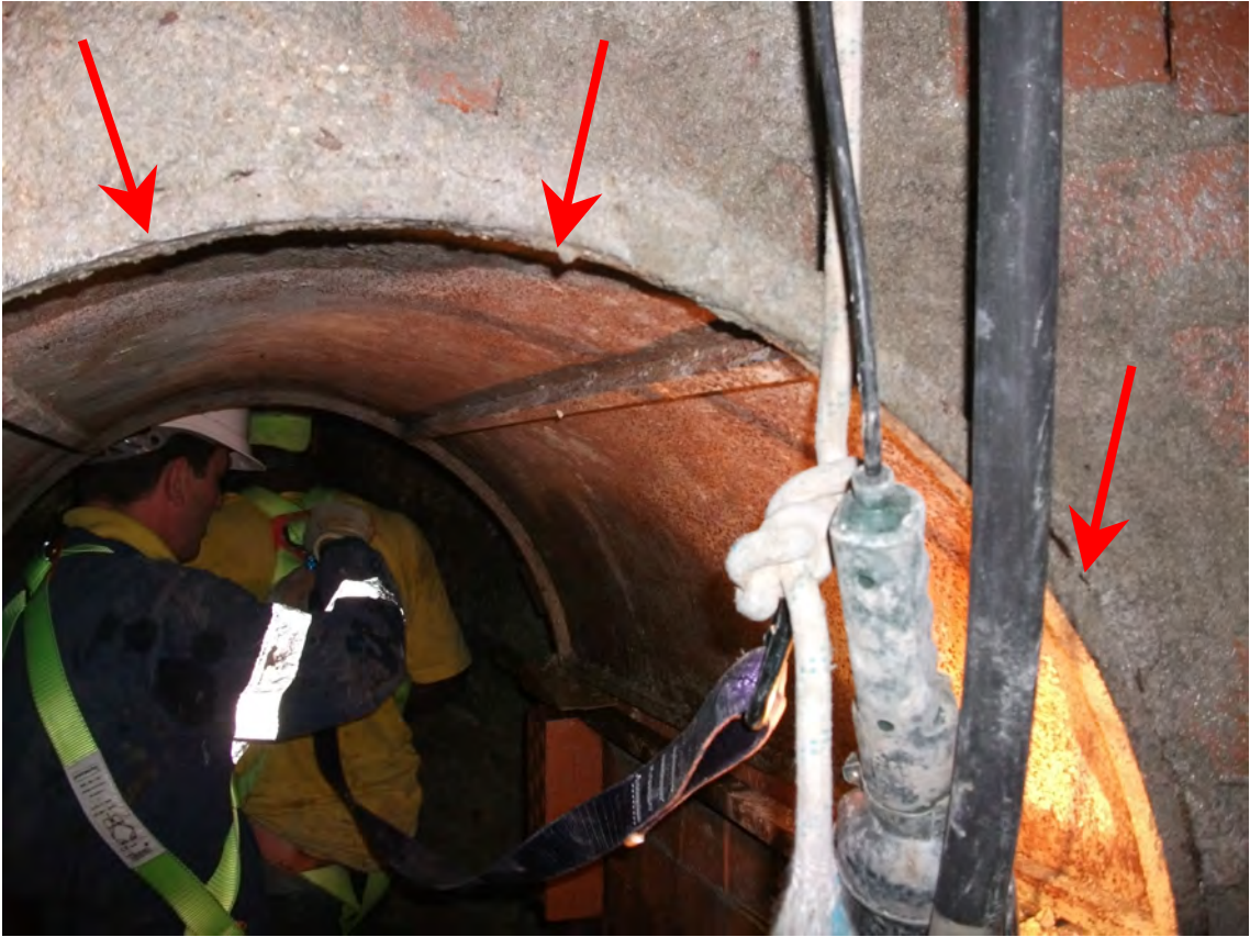
Fig. 40: Camión dispuesto en una galería en fase de ejecución.
