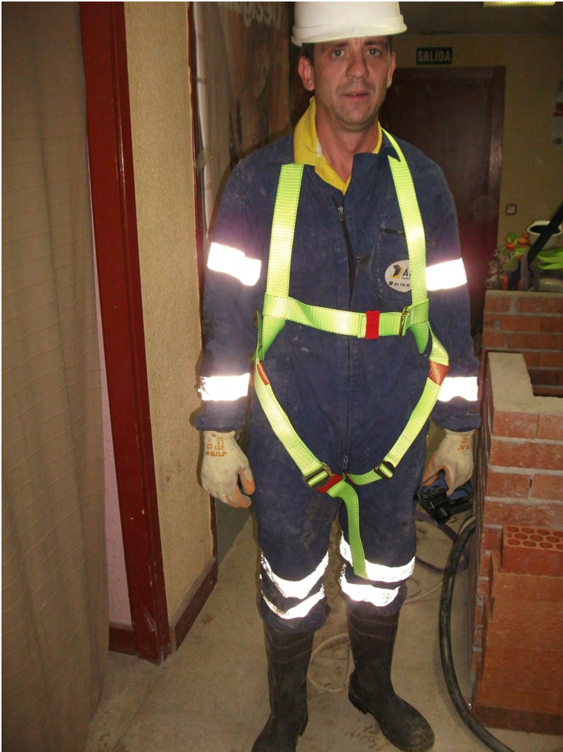
Fig. 24: Equipos de protección individual de operario que se dispone a descender a través del pozo.
