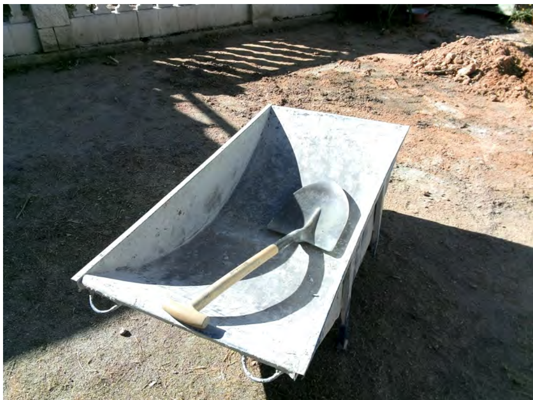
Fig. 35: “Chino” empleado para el ascenso y descenso de material a través del pozo.
