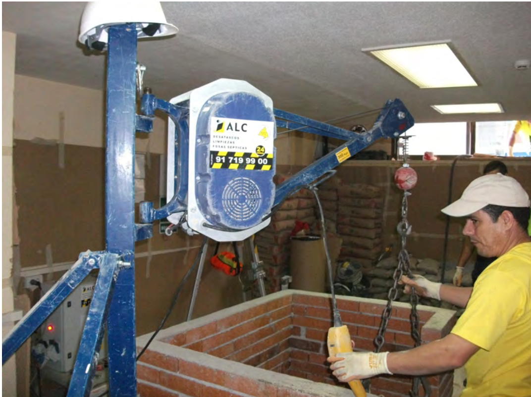
Fig. 21: Maquinillo dispuesto para permitir la entrada y salida de material a través de un pozo.
