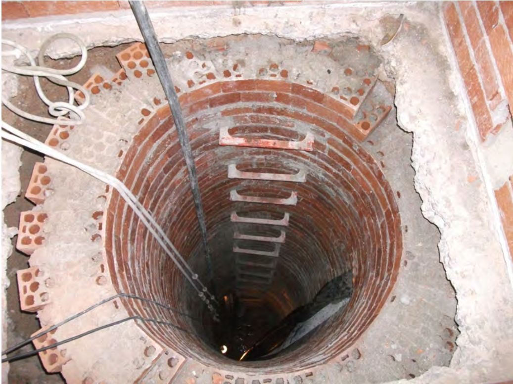
Fig. 20: Vista de un pozo ya ejecutado para permitir los trabajos en una galería en mina.
