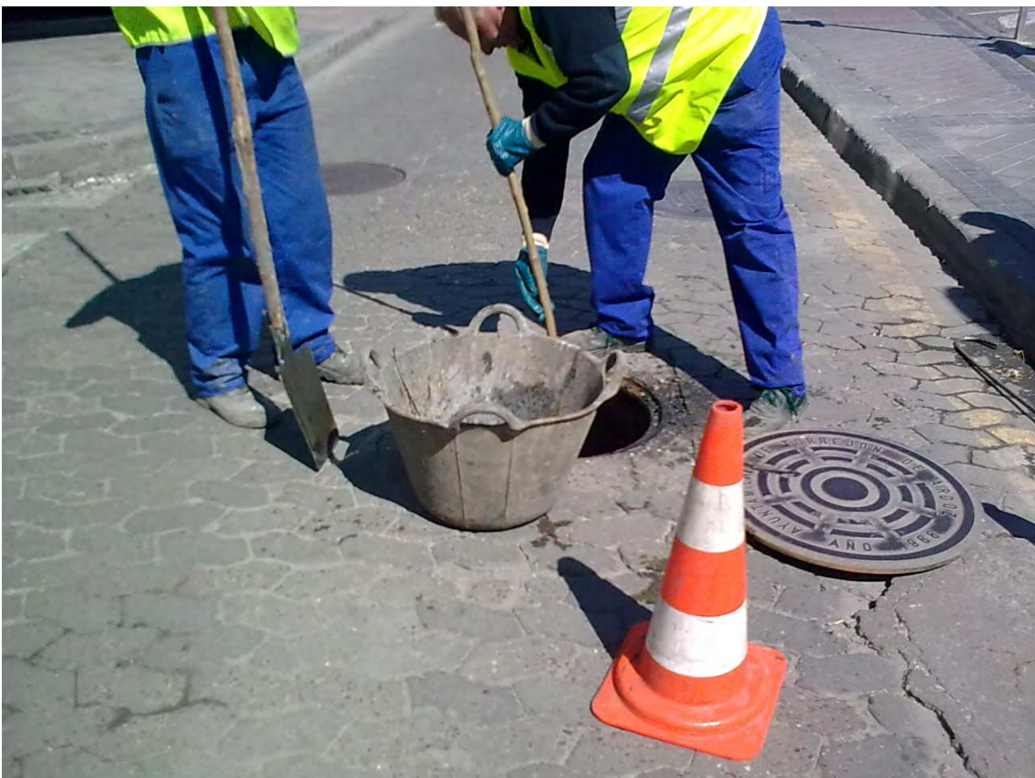
Fig. 4: Operaciones de extracción de materiales de una galería por medios manuales.
