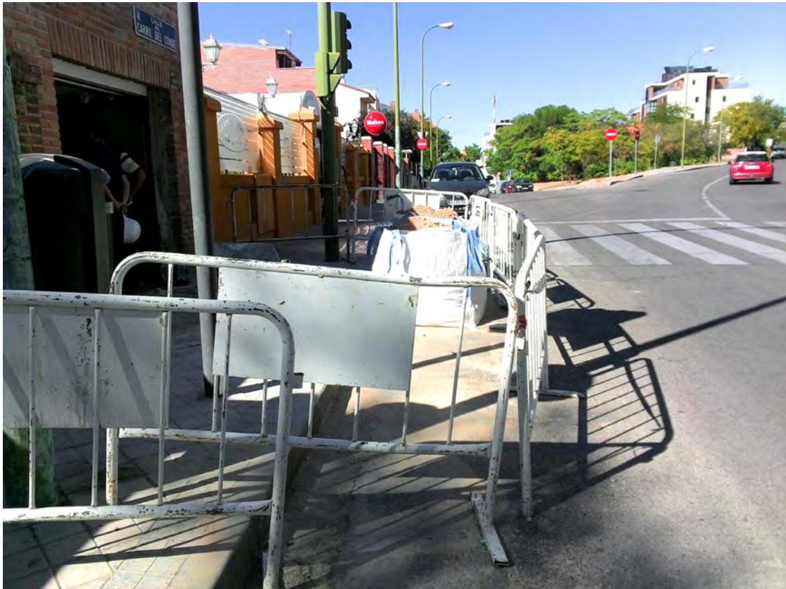
Fig. 36: Vallas encadenables de mediana altura, dispuestas para delimitar perimetralmente la zona de actuación.
