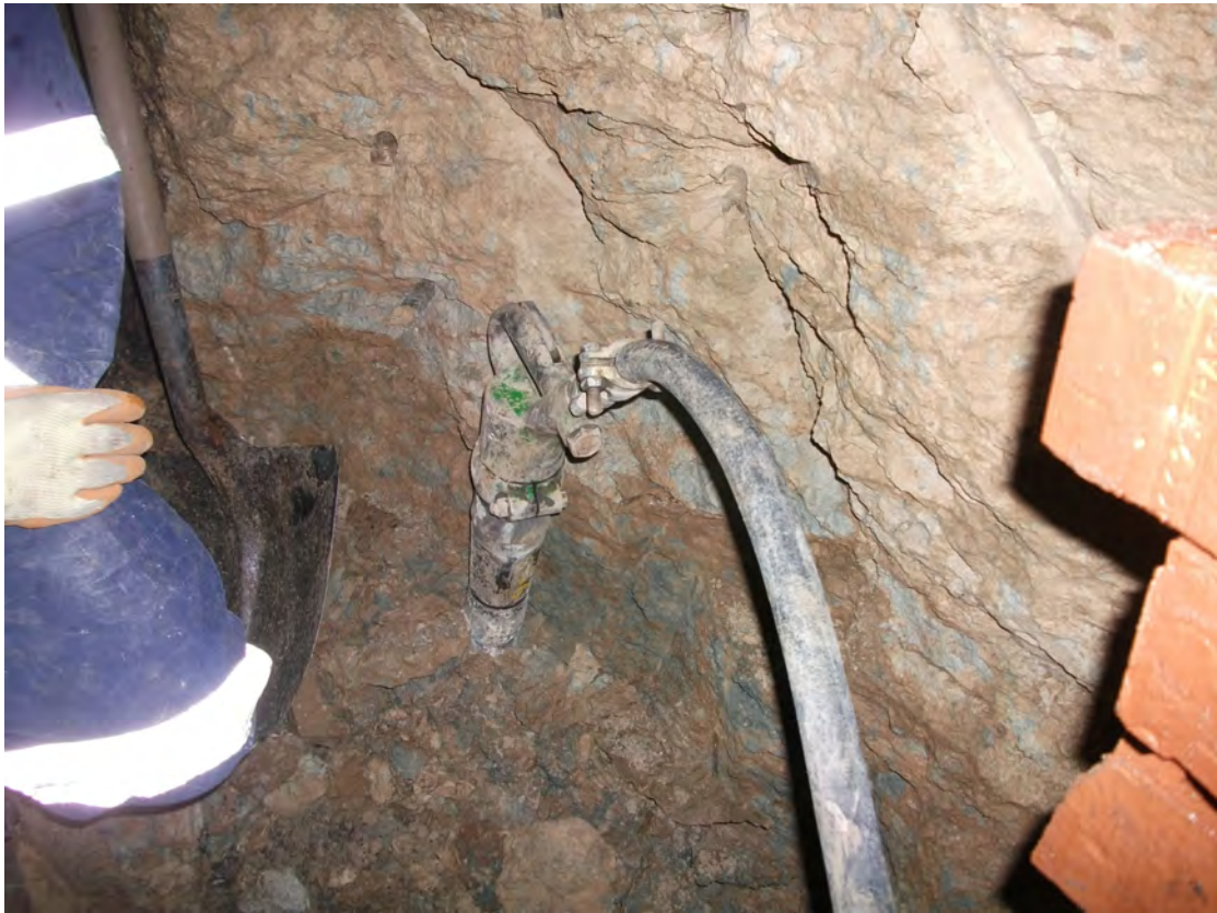
Fig. 47: Pistolete empleado para los trabajos de excavación de la galería de avance.
