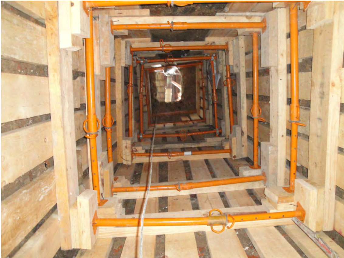
Fig. 37: Sistema de entibación semicuajada, empleado para sostener el terreno y facilitar el tránsito de operarios.
