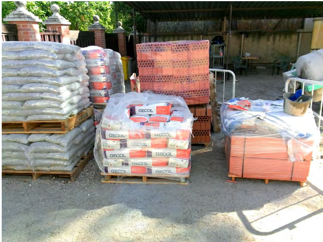
Fig. 33: Acopio de materiales necesarios para la adecuada ejecución de un pozo.
