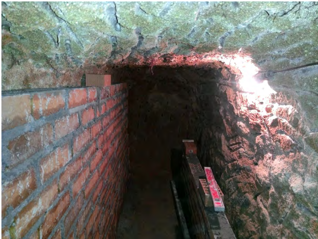
Fig. 39: Ejecución de galería en mina correspondiente a la imagen anterior.
