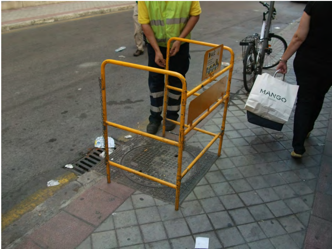
Fig. 16: Valla de bloque de pozos plegable, instalándose en un pozo.
