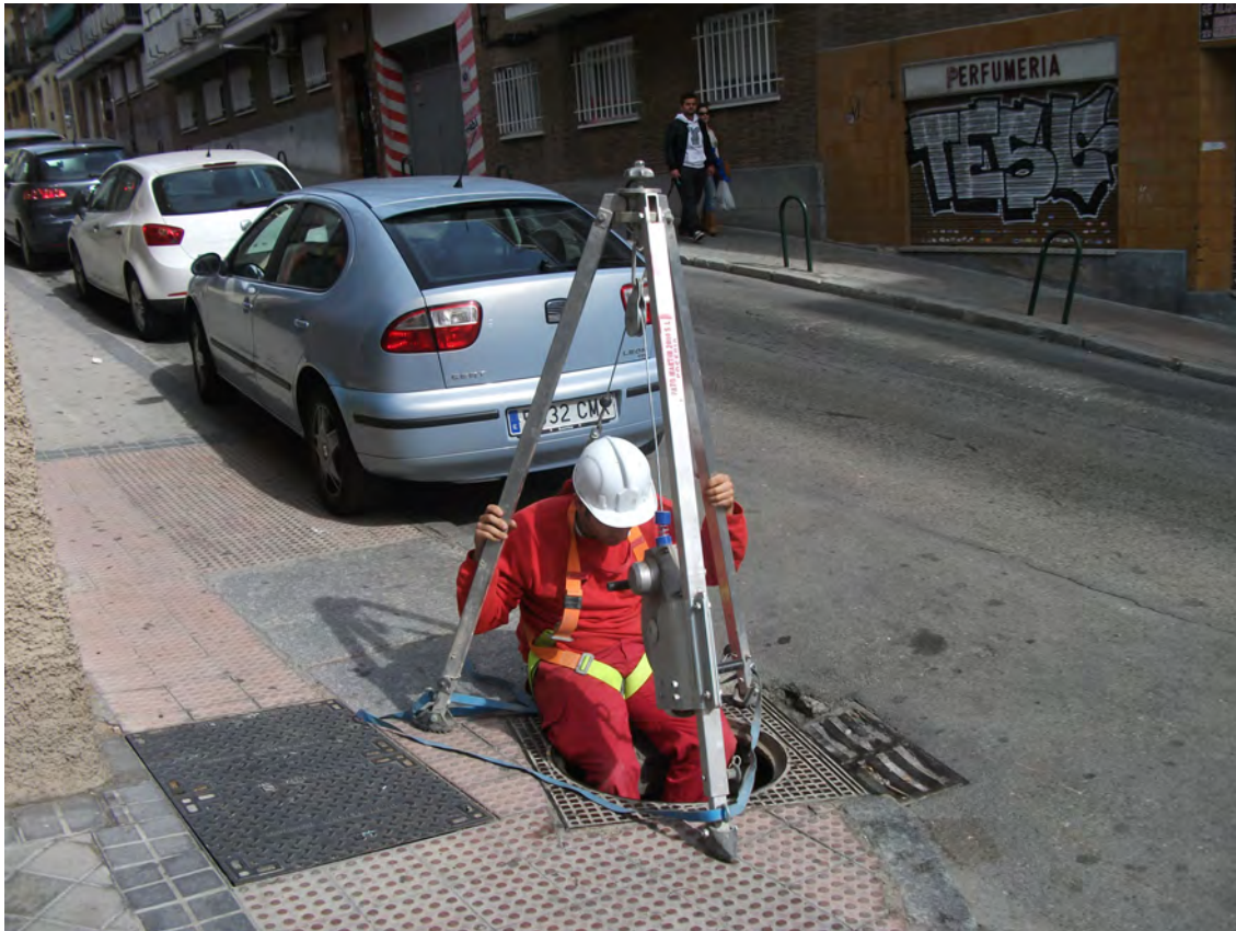
Fig. 30: Maniobra de acceso adecuada al interior de un pozo, empleando un trípode.
