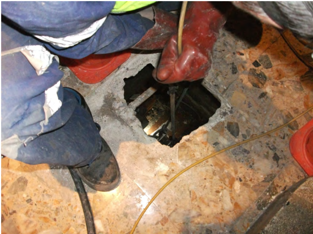
Fig. 13: Operario insertando el dispositivo robótico de una conducción.
