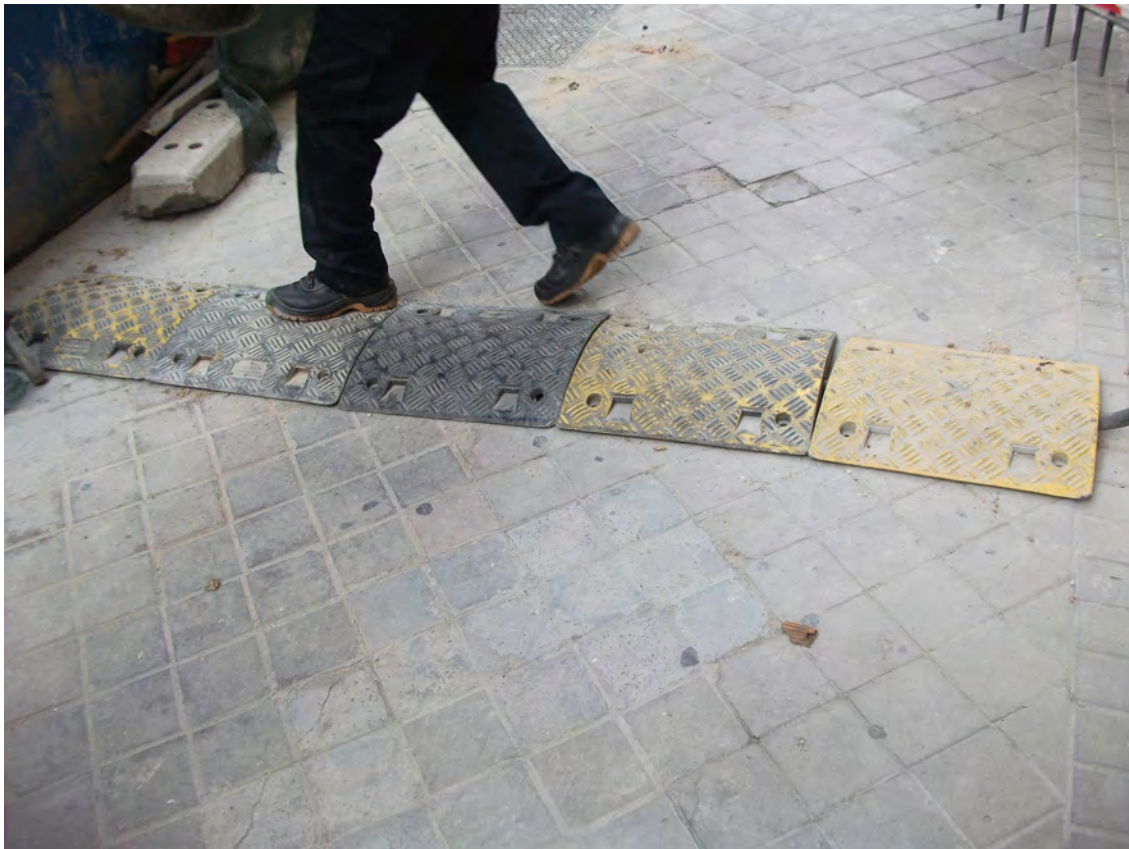
Fig. 44: Protector de conducciones en vía pública.
