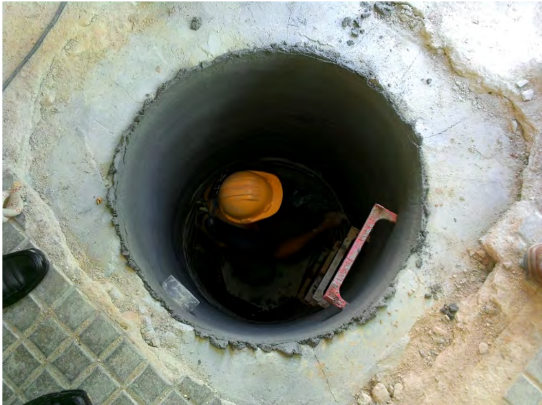
Fig. 28: Operario realizando trabajos de revestimiento en el interior de un pozo de escasa profundidad.
