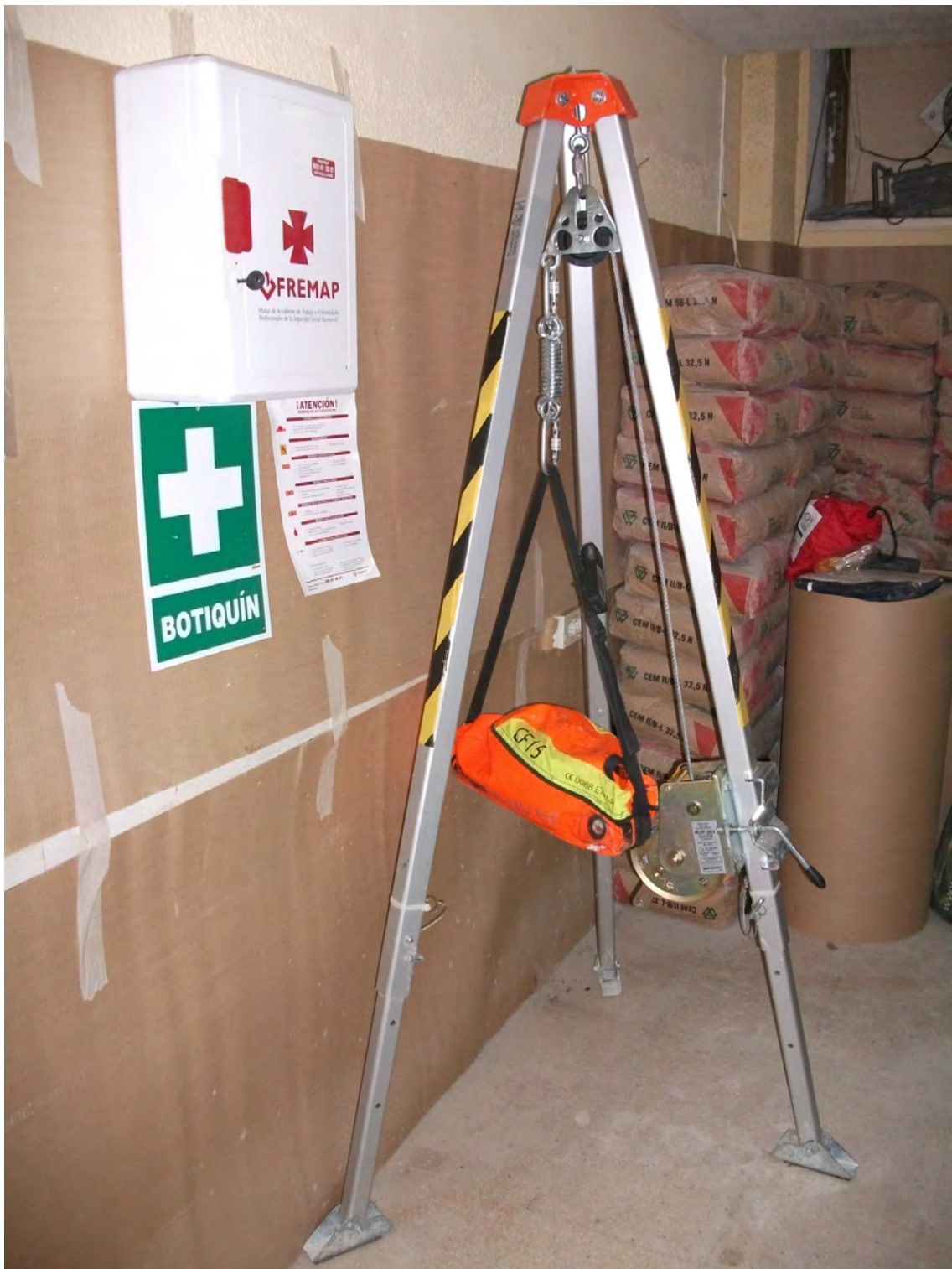
Fig. 29: Equipo de salvamento completo, compuesto por el trípode con el anticaídas recuperador, dispuesto junto al botiquín de emergencias y primeros auxilios.
