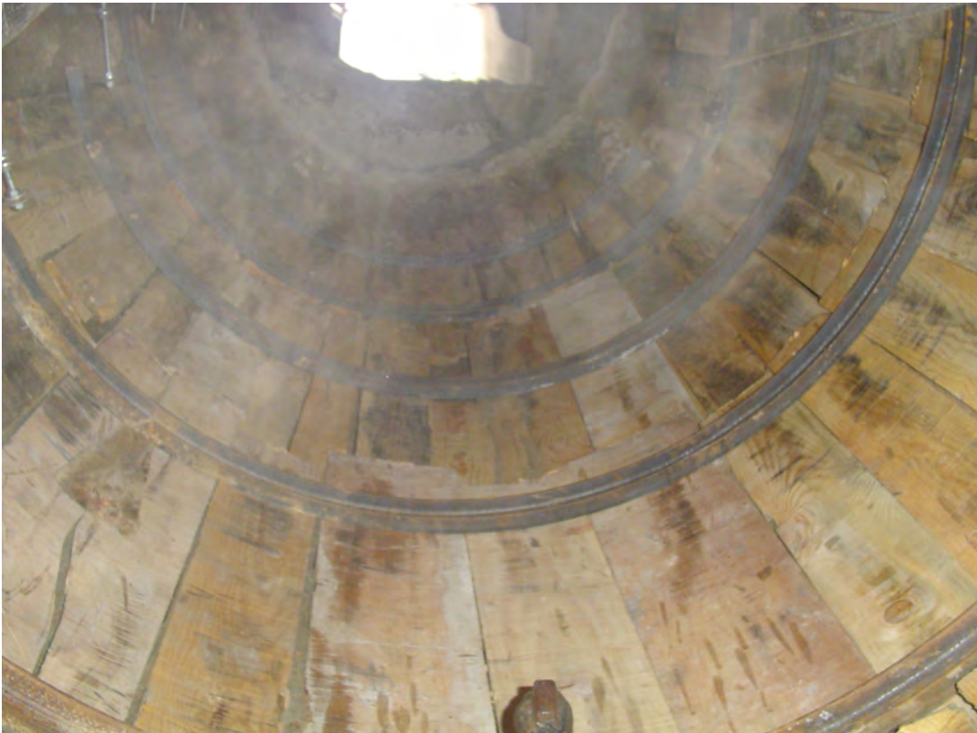
Fig. 19: Sistema de entibación cuajada empleada en un pozo.
